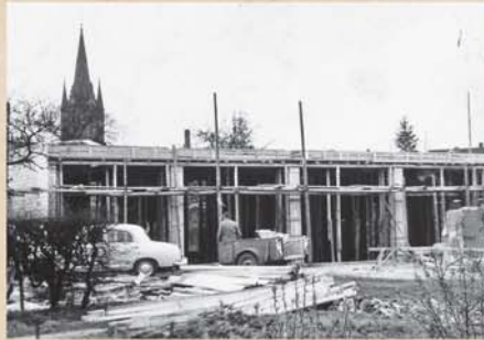
FEUERWEHR IM ROHBAU
