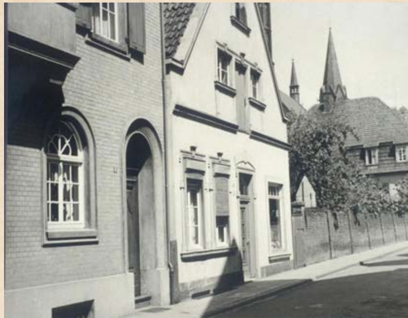
↑ Wohnhaus Brennerei Sommersell, Meyer, alte Mauer
