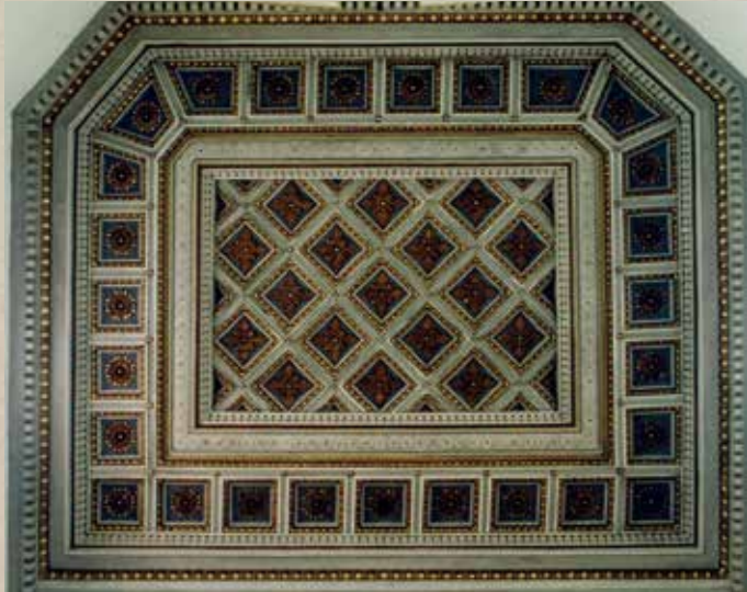
↑ Decke im Chorraum
