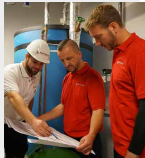
↑Heizungs- und Klimatechnikbetrieb Bisplinghoff
