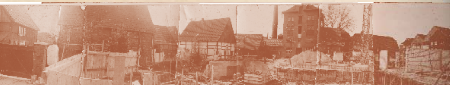
BAUGRUBE DES BÜRGERHAUSSAALS (VON HÖLSCHER AUS), IM HINTERGRUND DIE ALTE BRENNEREI SCHULZE RÖTERING
