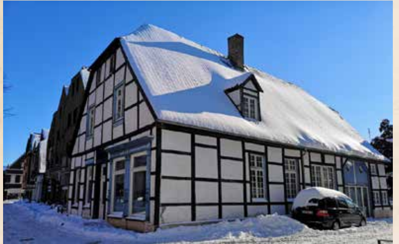
↑2021-Haus Leifert- wird zurzeit saniert.
